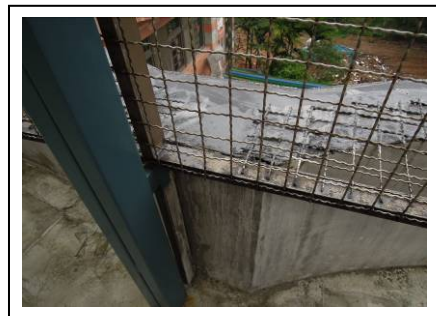
內外側牆面鋪設防水層
