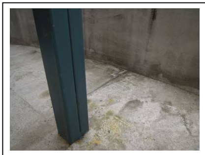
支撐鐵條塗防水漆
